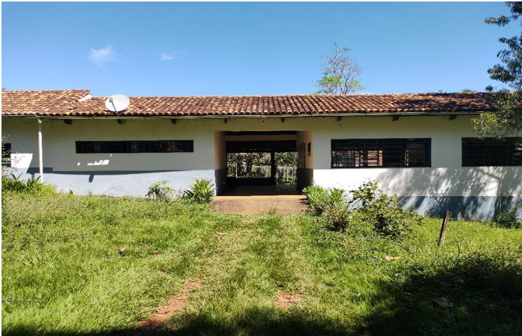
Figura 8 - Fachada atual da Escola Família Agrícola de Goiás. Registro realizado em abril de 2021
